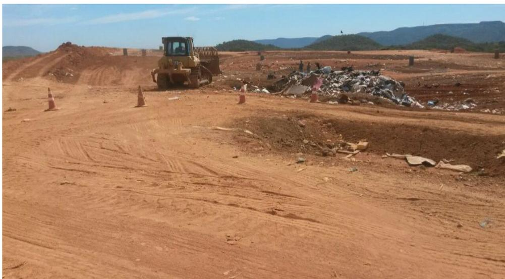
**Figura 07** - Detalhe dos resíduos sólidos no aterro, onde o trator está fazendo a cobertura com terra.
