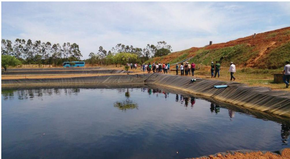
**Figura 05** - Lagoa de contenção onde é depositado o chorume do aterro sanitário de Palmas - TO.
