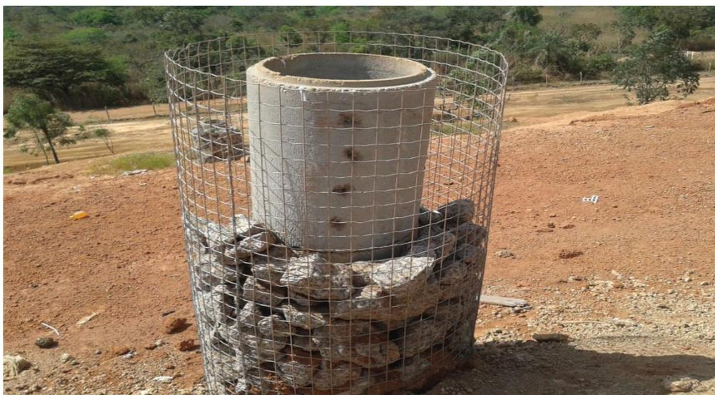
**Figura 10** - Foto mais detalhada do dreno para controle dos gases emitidos no aterro Sanitário de Palmas – TO.
