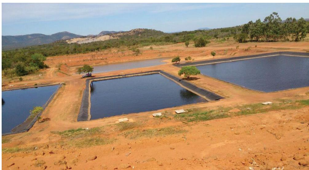
**Figura 06** - Lagoas de contenção onde é depositado o chorume do aterro sanitário de Palmas – TO, e ao fundo o chorume tratado.
