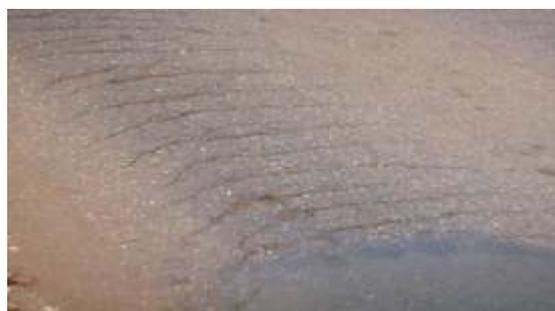
Figura 2: Fendas na Av. Teotônio Segurado.
