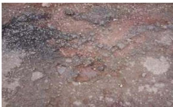
Figura 7: Desagregação do pavimento situado no Parque Cesamar.
