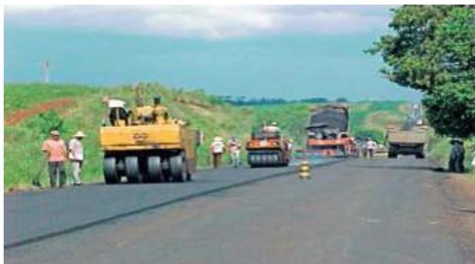
Figura 11. Processo de recapeamento.
