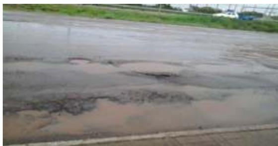
Figura 8: Panelas no pavimento situado na TO-050, Estação Javaé.
