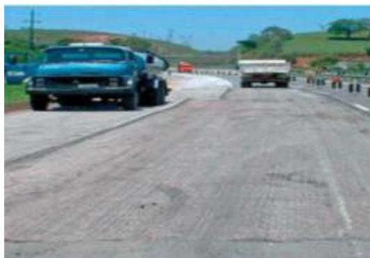
Figura 13: Pista após fresagem.
