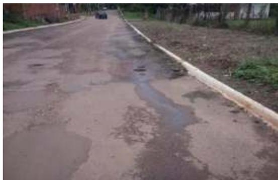
Figura 6: Remendos no pavimento situado na Rua 11, Taquaruçu, Palmas – TO.
