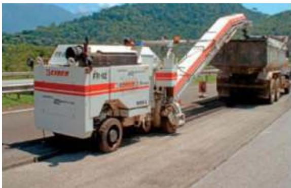
Figura 12: Processo de fresagem.
