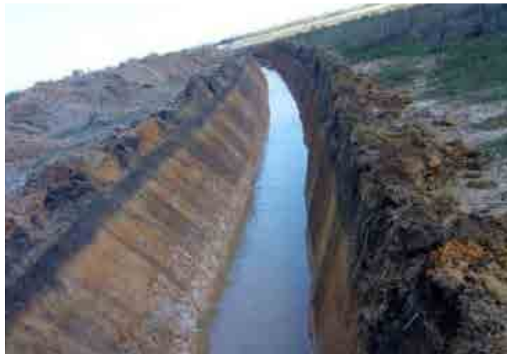
Figuras 04: Vala de desvio para secar o Rio Perdizes.
