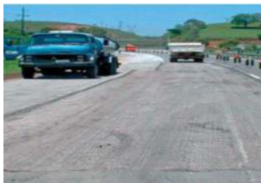
Figura 13: Pista após fresagem. Fonte: (BERNUCCI et al, 2008)
