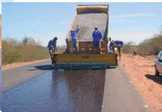
Figura 10: Distribuição de agregados. Fonte: (BERNUCCI et al, 2008)
