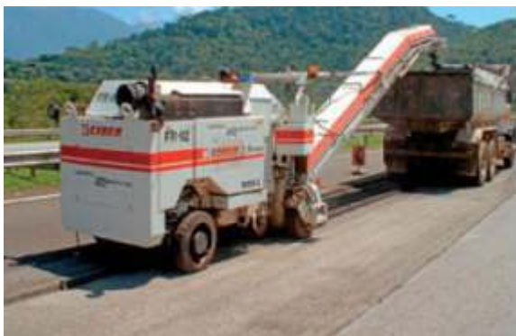
Figura 12: Processo de fresagem. Fonte: (BERNUCCI et al, 2008)
