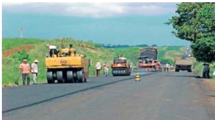
Figura 11. Processo de recapeamento. Fonte: (BERNUCCI et al, 2008)
