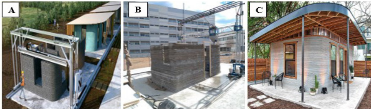
Figura 1- Protótipo da impressora Vulcan da ICON (A), Impressão 3D da casa, com uma argamassa especial de alta resistência (B), Casa impressa em 3D, no canteiro de obras.
