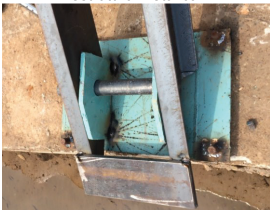
Figura 12 - Detalhes da base feita de estrutura metálica
