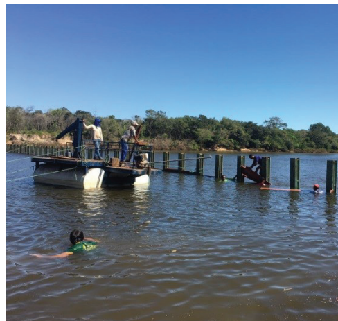
Figura 22 - Fechamento da barragem com uso de balsa
