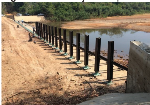
Figura 14 - Instalação dos pórticos
