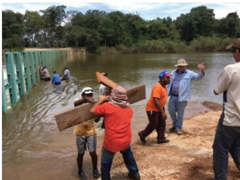
Figura 18 - Fechamento da primeira fiada da barragem com placas de madeira
