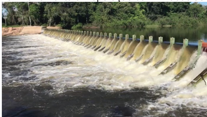
Figura 20 - Barramento em operação com 7 fiadas de madeira
