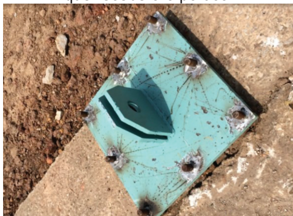
Figura 13 - Detalhes da base metálica que receberá o pórtico
