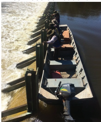
Figura 21 - Fechamento da barragem com uso de voadeira
