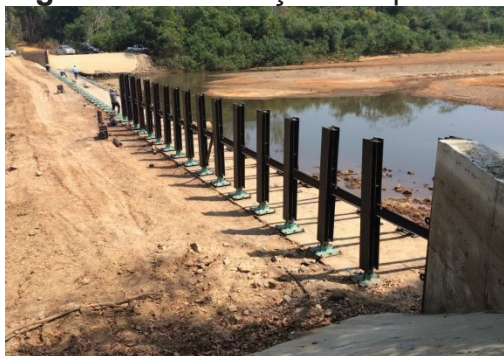
Figura 14 - Instalação dos pórticos
