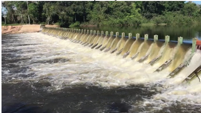
Figura 20 - Barramento em operação com 7 fiadas de madeira
