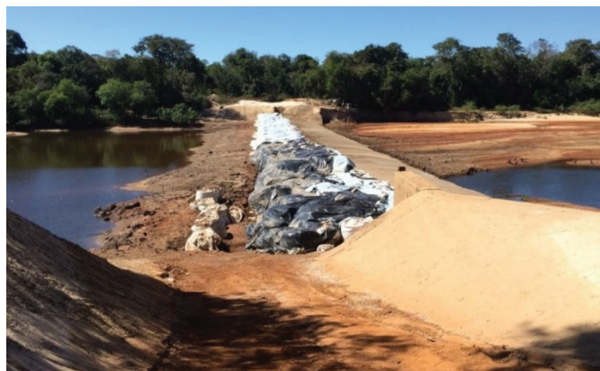
Figura 11 - Barramento feito com saia de concreto e big-bags
