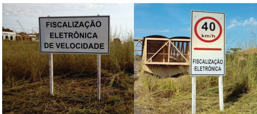
Figura 9a e 9b – Sinalização Indicativa (indicação de redutor de velocidade)
