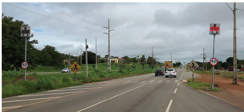
Figura 10 – Redutor de velocidade
