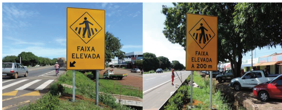
Figura 8a e 8b – Sinalização Advertência (faixa elevada)
