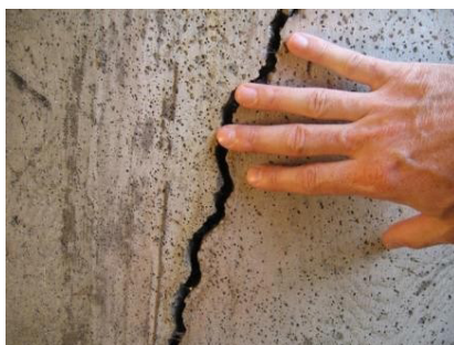
Imagem 1 - Fissuras verticais
