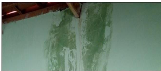
Figura3- Rachadura
