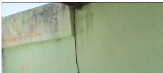
Figura3- Rachadura
