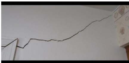
Imagem 3 - Fissuras por recalque diferencial
