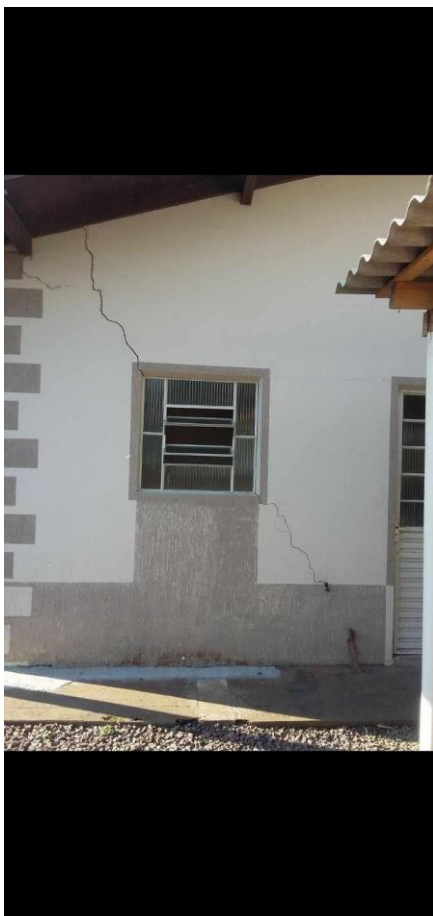
Imagem 3 - Fissuras por recalque diferencial
